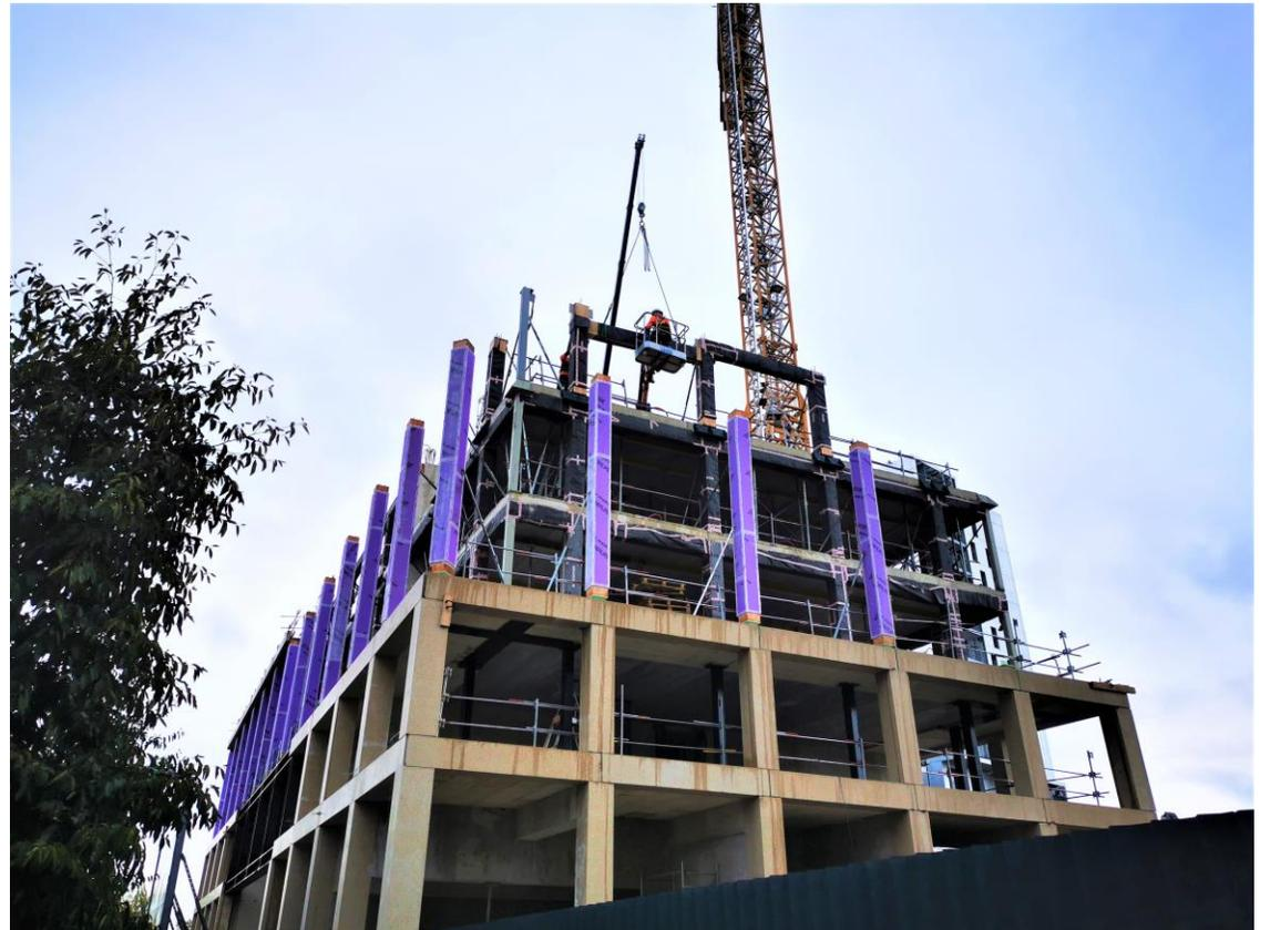
2 premiers niveaux béton / Poteaux doubles étages loggias en pin Douglas, poteaux intérieur hêtre, poutre épicea, dalle bois béton
